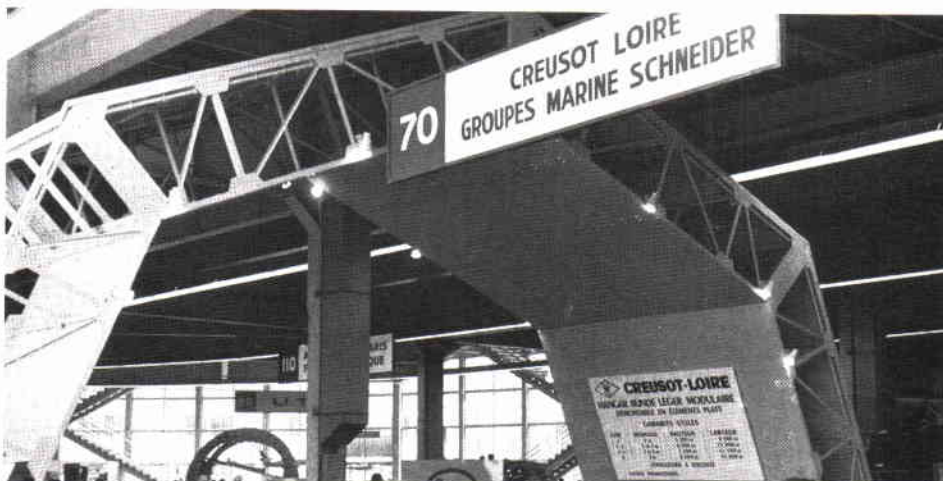
Sektor av en fältmässig hangarkonstruktion i stål, utvändigt klädd med glasfiberarmerade plastskivor — troligen för att effektivisera splitterskyddet.
